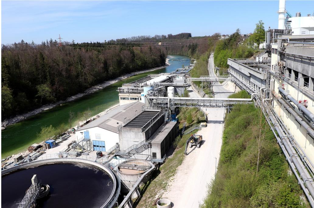
In einer Kläranlage werden dem Abwasser zuerst grobe Abfälle (z.B. Holz) entnommen. In einer zweiten Etappe werden das Öl und die Fette von der restlichen Flüssigkeit und dem Sand getrennt.
